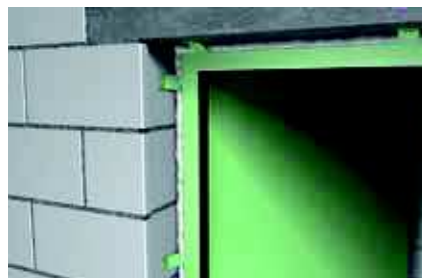
Ajtókeretek szigetelése
