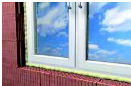
Ablakok, párkányok szigetelése
