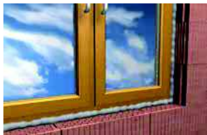
Ablakok, párkányok szigetelése
