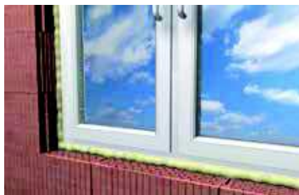
Ablakok, párkányok szigetelése
