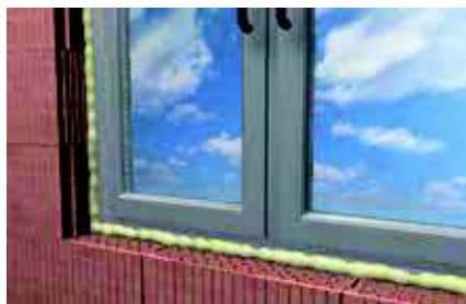
Ablakok, párkányok szigetelése
