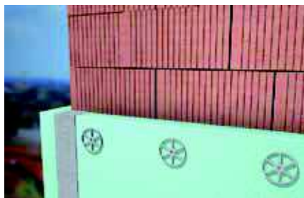
Üregek kitöltése szigeteléseknél
