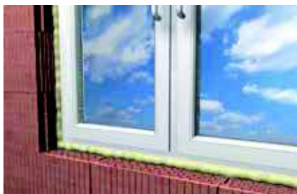
Ablakok, párkányok szigetelése
