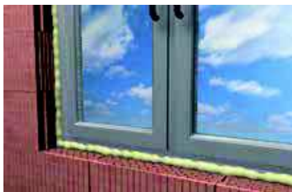
Ablakok, párkányok szigetelése
