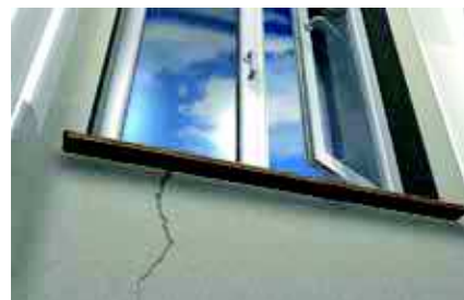
Belső falrepedésekhez
